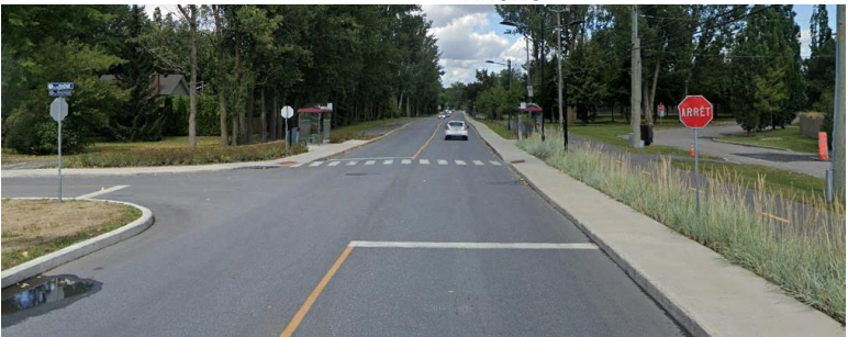
Photo 5.10 : Panonceaux d’arrêts toutes approches manquant – Intersection de la rue Riverside et de l’avenue du Rhône
